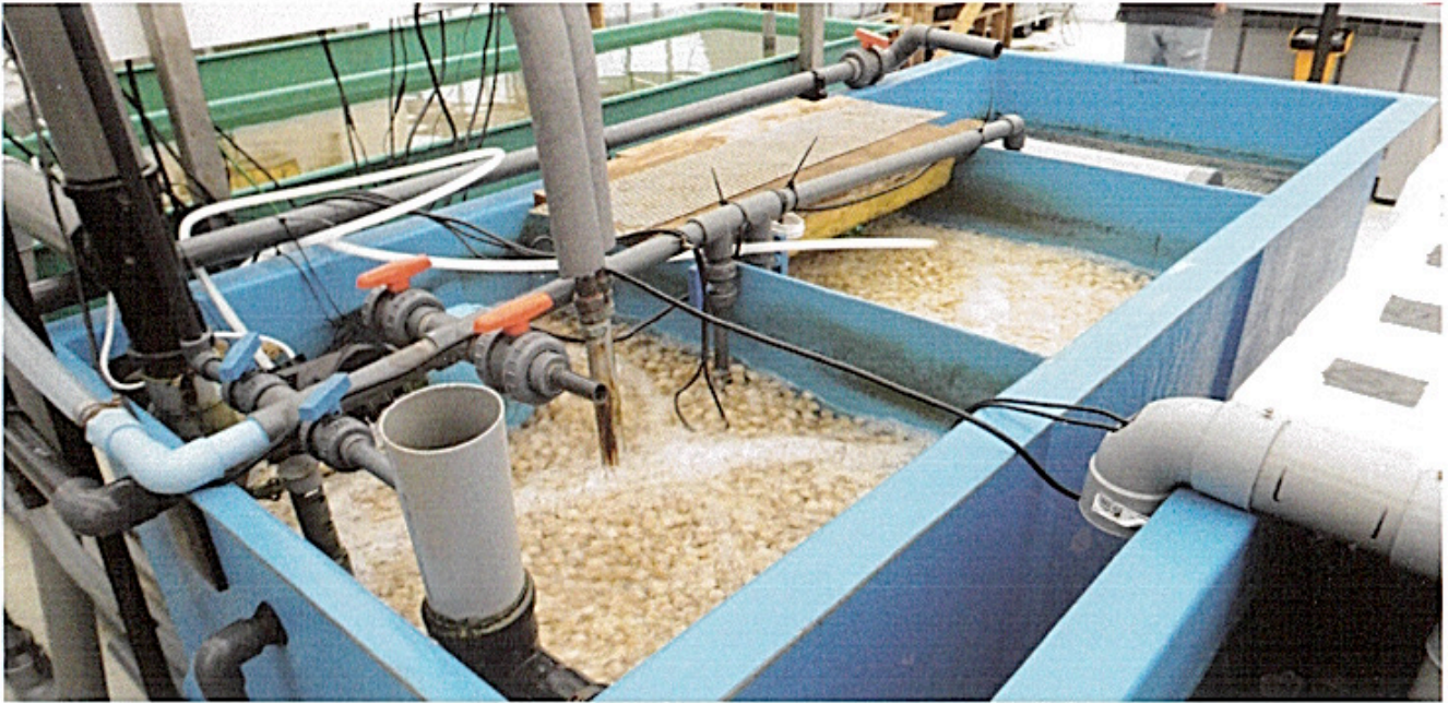
Biofilter dat zorgt voor reiniging van het zoute water.
